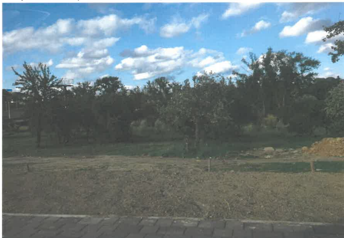
Рисунок 3 – Фото территории строительства (территория, прилегающая к Игуменскому тракту)
