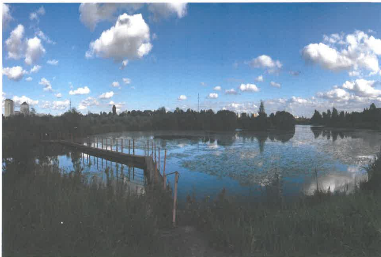
Рисунок 5 – Пруд отстойник, входящий в состав существующих очистных сооружений в р-не ул. Чижевских.
