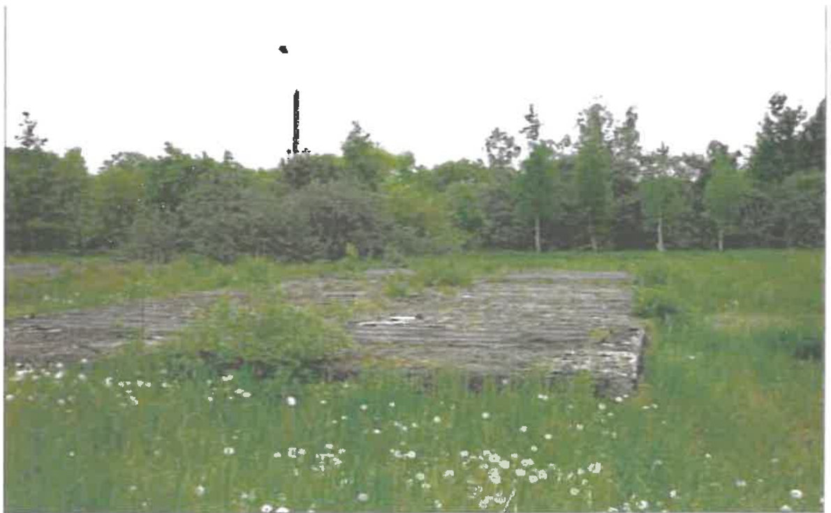
Рисунок 8 - Очистные сооружения существующая ситуация (фото)
