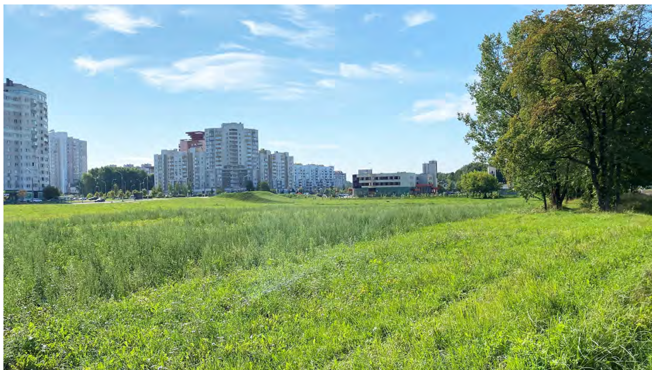
Фото 4.2 – Вид на участок с северо-западной стороны
